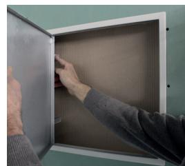
Rahmen in Öffnung platzieren und fixieren über das Umbiegen der Montageanker.
