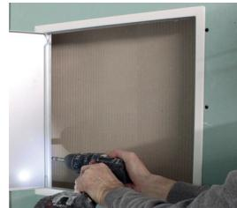
Montageanker am CW-/ CD-Profil anpassen. Die Montageanker an beiden Profilen (links und rechts) verschrauben. Der Rahmen ist nun befestigt.
